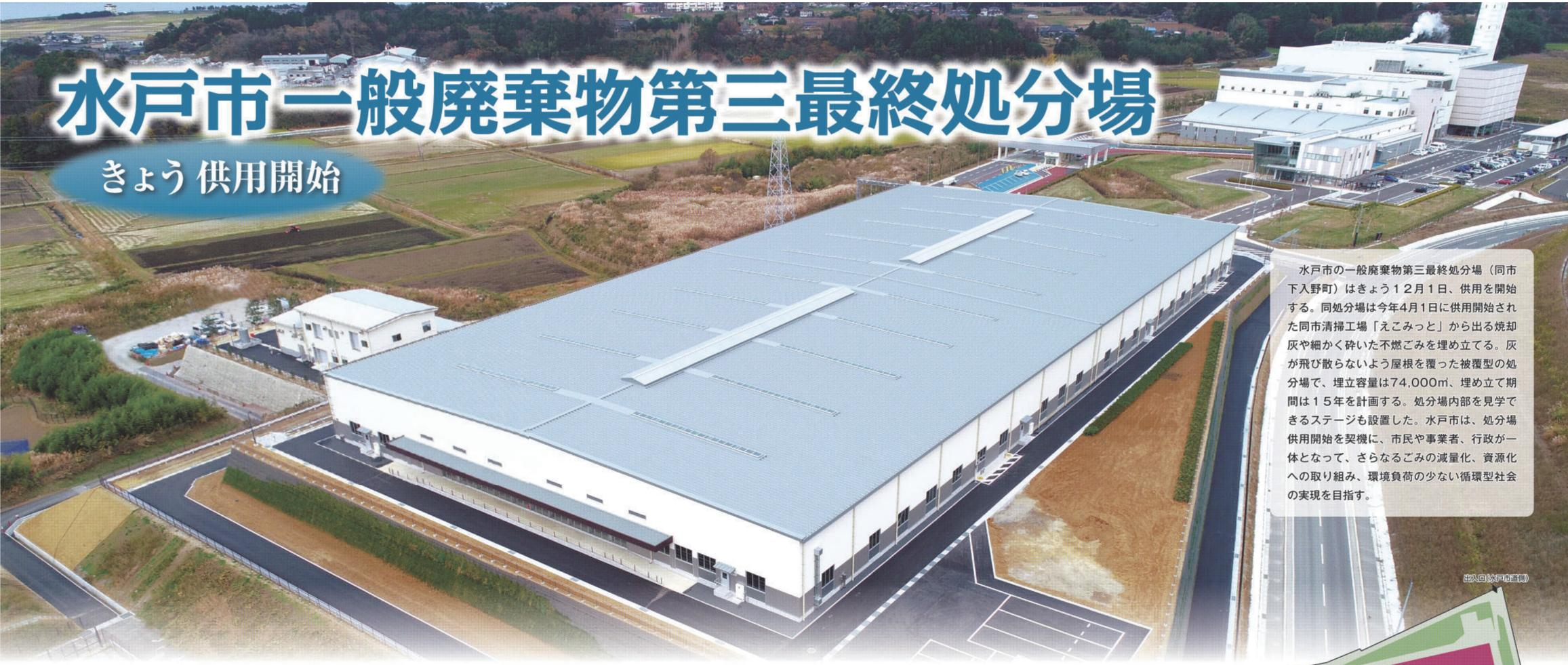
水戸市の一般廃棄物第三最終処分場（同市下入野町）はきょう12月1日、供用を開始する。同処分場は今年4月1日に供用開始された同市清掃工場「えこみっと」から出る焼却灰や細かく砕いた不燃ごみを埋め立てる。灰が飛び散らないよう屋根を覆った被覆型の処分場で、埋立容量は74,000m<sup>3</sup>、埋め立て期間は15年を計画する。処分場内部を見学できるステージも設置した。水戸市は、処分場供用開始を契機に、市民や事業者、行政が一体となって、さらなるごみの減量化、資源化への取り組み、環境負荷の少ない循環型社会の実現を目指す。
